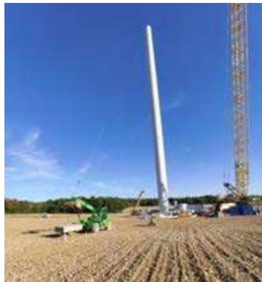
Photo 7 : Exemple de l'installation de haubans pour stabilisation de la tour (Source : Q ENERGY)
