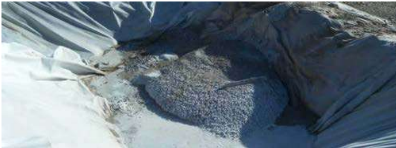
Photo 22 : Protection par géotextile pour le nettoyage des goulottes des camions toupie)
