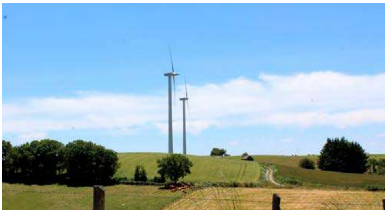
Photo 54 : Les éoliennes du parc de Lascombes
