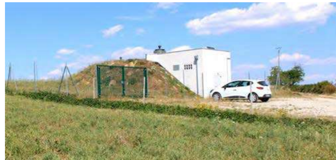
Photo 34 : Le réservoir d'eau sur la ZIP
