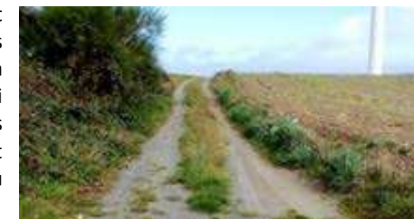
Photo 4 : Exemples de pistes existantes à améliorer (Source Q ENERGY)
