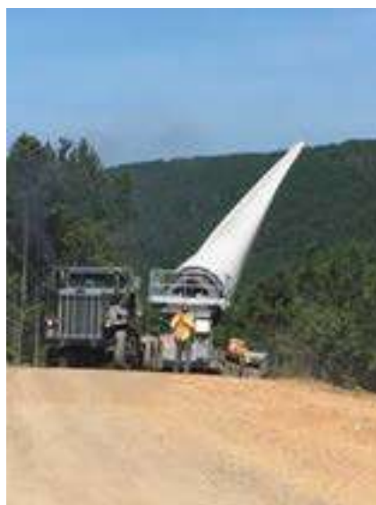
Photo 9 : Utilisation d'un Blade lifter sur un chantier de RES aux Etats-Unis ©RES
