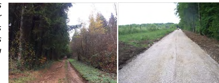
Photo 5 : Exemples de configurations de pistes (Source : Q ENERGY) avec à gauche, une piste existante avant aménagement et à droite, une piste après aménagement
