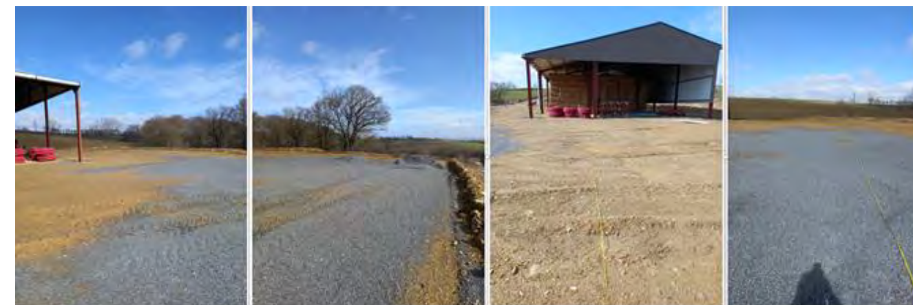
Photo 20 : Surface déjà terrassée utilisée pour la base de vie (Source : Q ENERGY)
