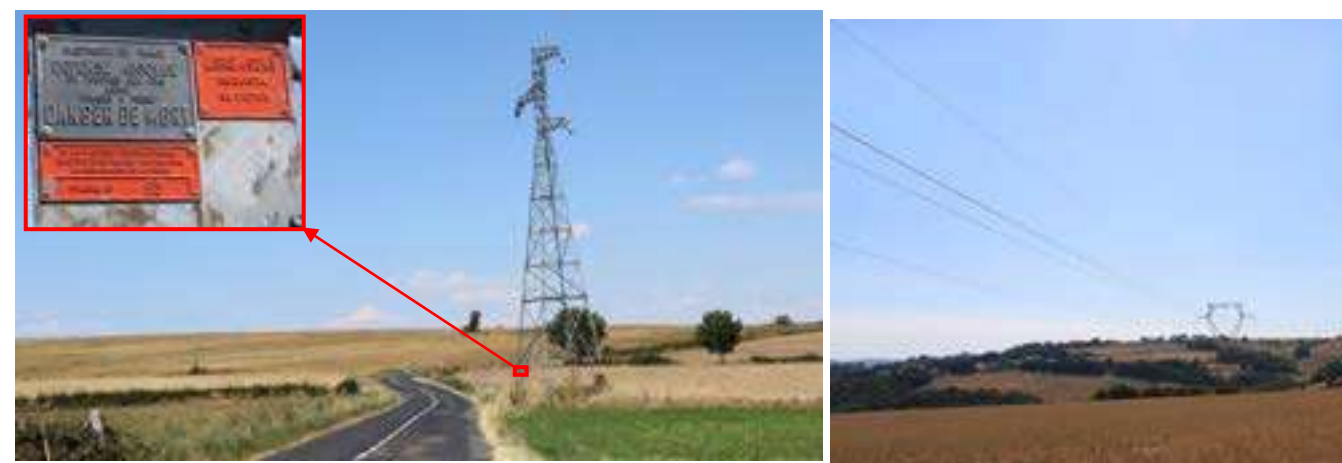
Photo 36 : A gauche, l'ancienne ligne THT 63 kV Requista – Saint-Victor ; à droite, la ligne 225 kV Pelissier-Requista-Saint-Victor (au niveau du pylône n°92)
