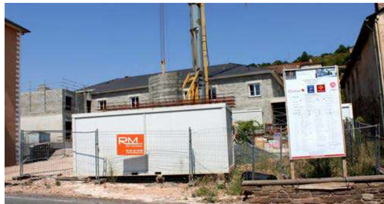
Photo 51 : L'EHPAD « Le Relays » en cours d'extension et de réhabilitation
