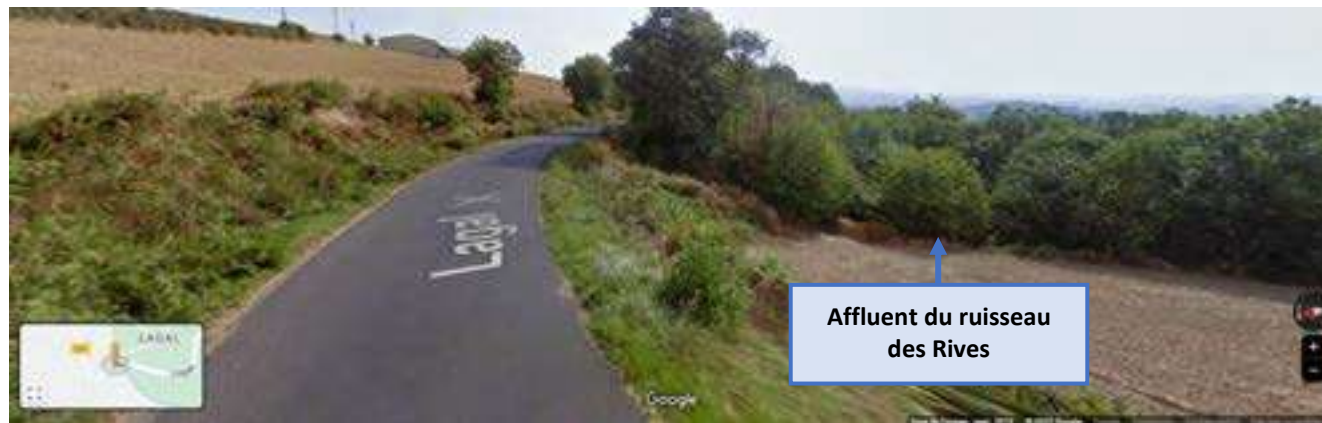
Figure 111 : Route D 31, au niveau de l'affluent temporaire du ruisseau des Rives (Source : Google)
