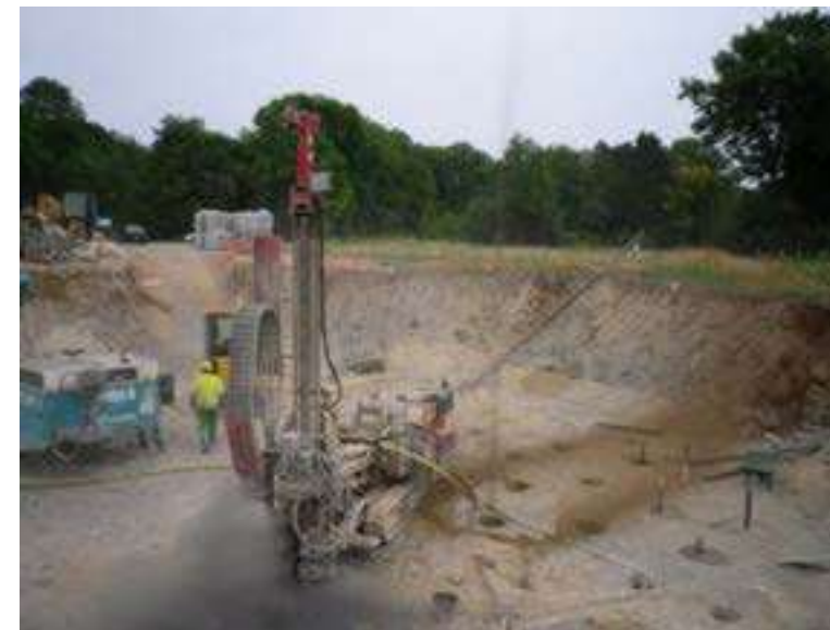
Figure 46 : Atelier de forage, armement et coulage de mortier (Q ENERGY)
