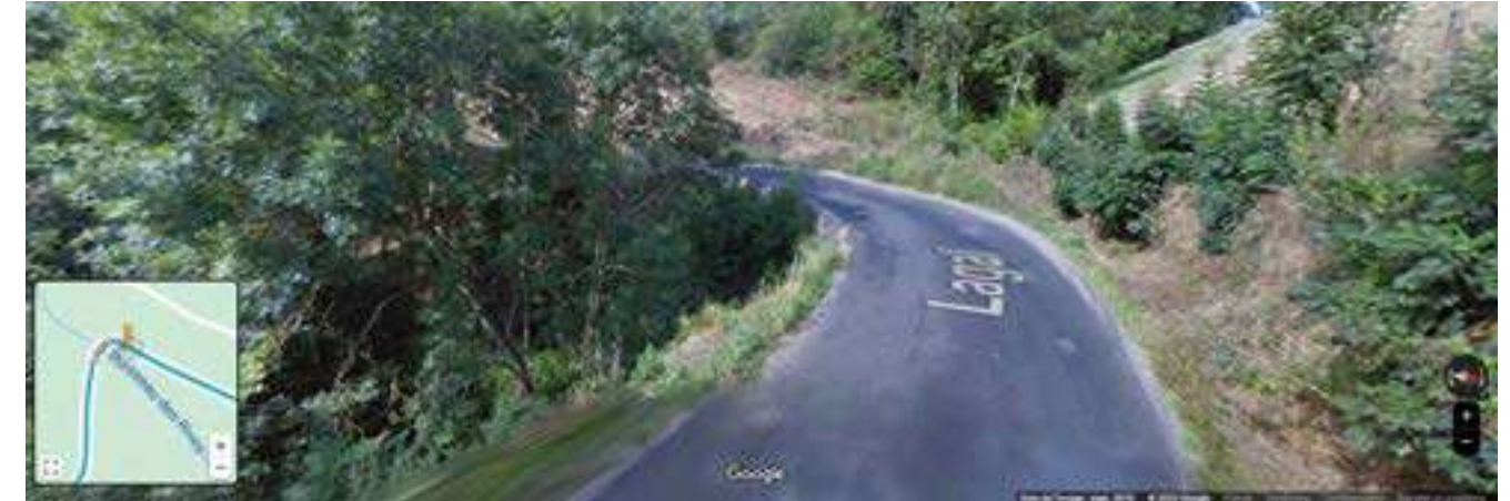
Figure 112 : La route D 31 au niveau du ruisseau des Rives
