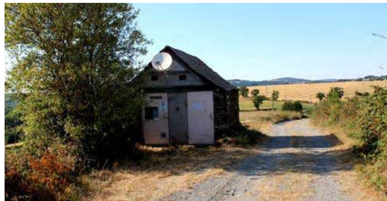
Photo 2 : Le poste de livraison (électrique) du parc de Lascombes
