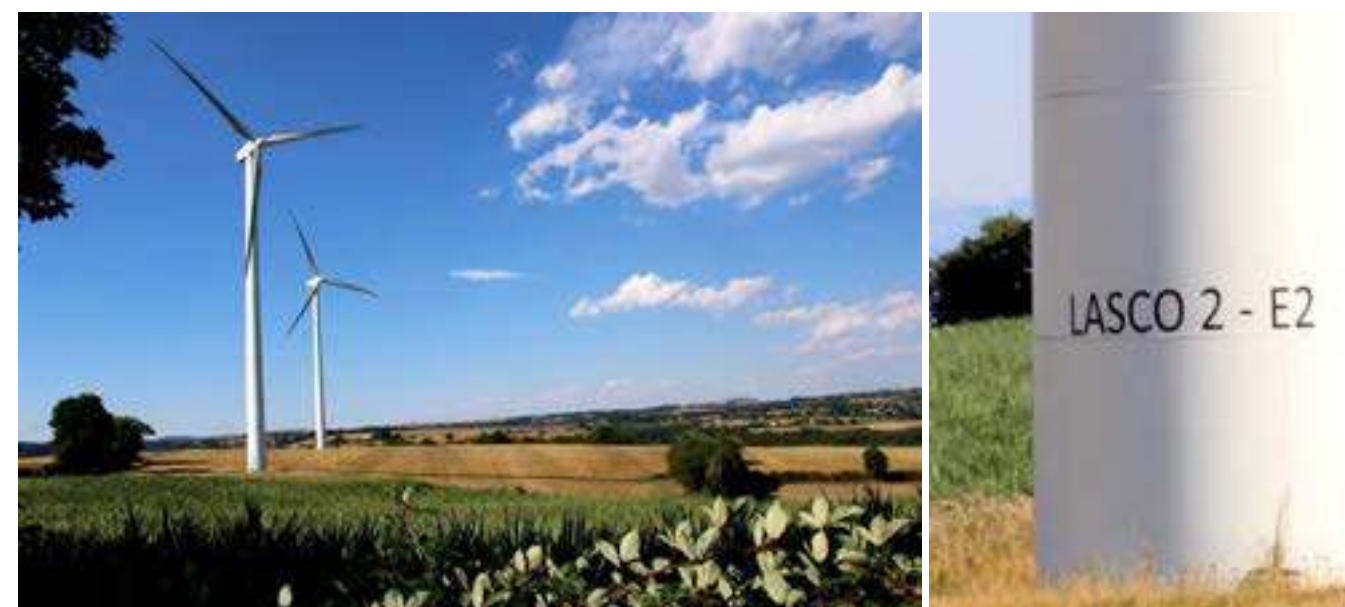
Photo 52 : Les éoliennes de la SARL Lascovent (parc de Lascombes en fonctionnement)
