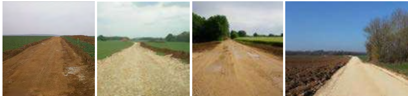
Photo 6 : Opération de décapage ; mise en place de la couche de fond de forme ; mise en place de la couche de finition Photos de gauche à droite (Source : Q ENERGY)
